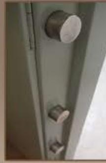
Pintu diperkuat dengan sistem bolt bergerak 4 arah berdiameter 51 mm
